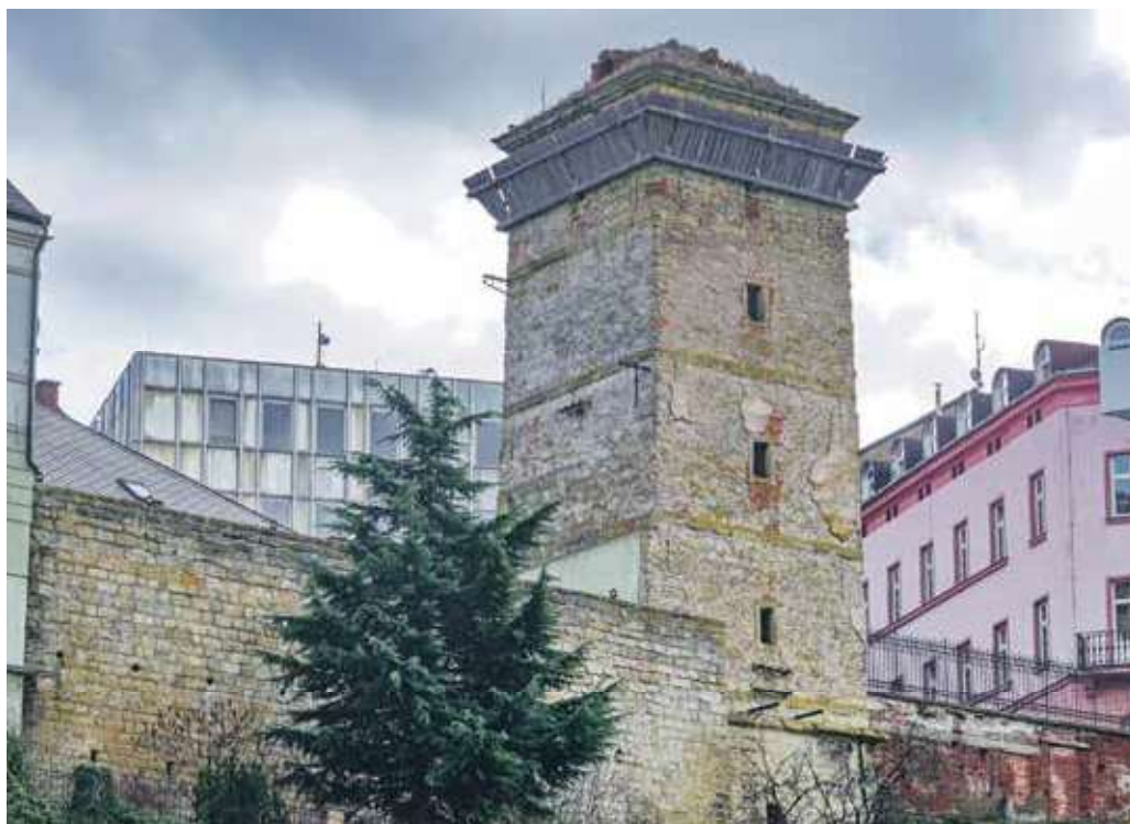
VODÁRENSKÁ VĚŽ zatím čeká na opravu a nové využití.
